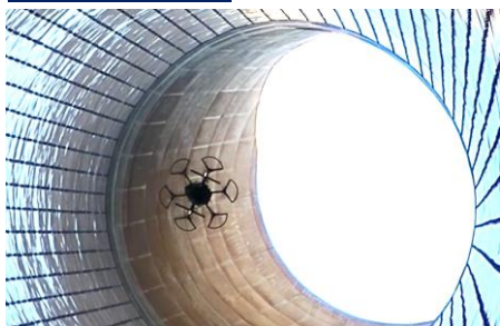
ドローン飛行状況（煙突下部より撮影）
