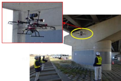
通行規制せずに撮影画像から損傷を確認(道路局)
