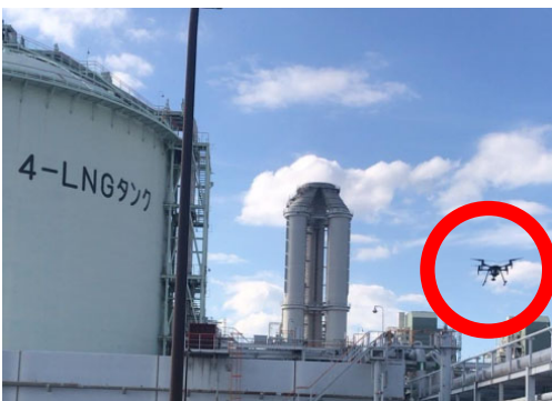
ドローン飛行状況（LNGタンク外観点検）
